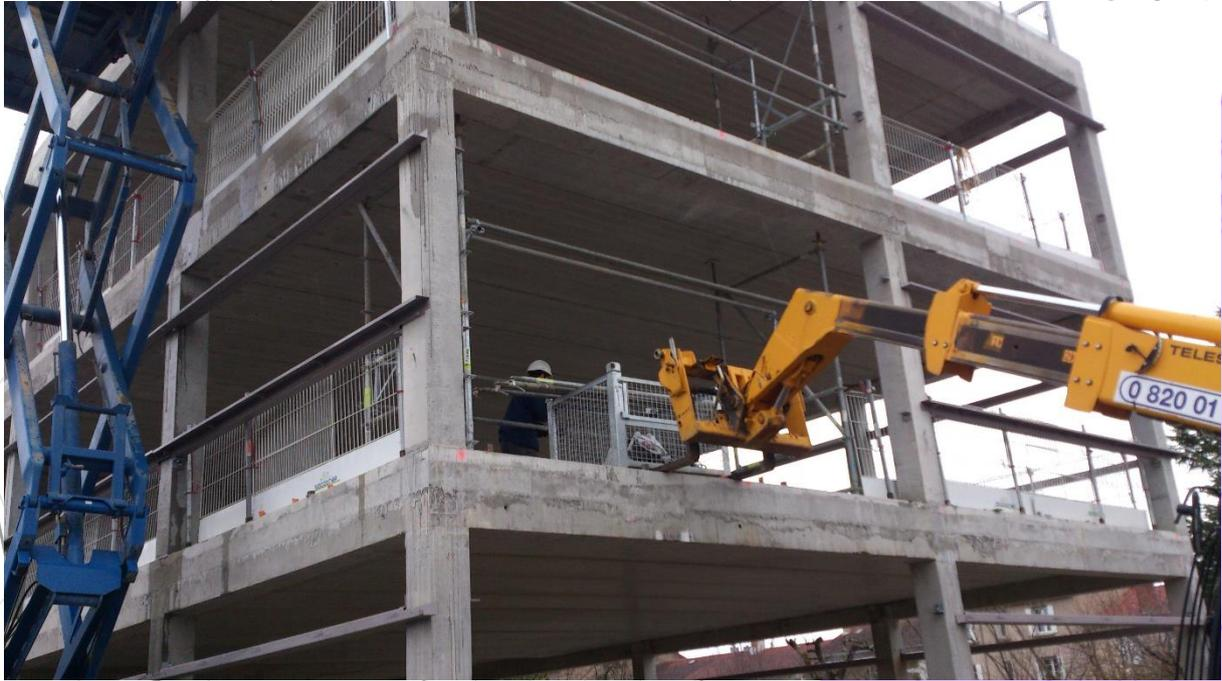
**Position 1 :** La barrière est abaissée côté intérieur pour permettre la livraison de matériel sur le plancher en sécurité.
