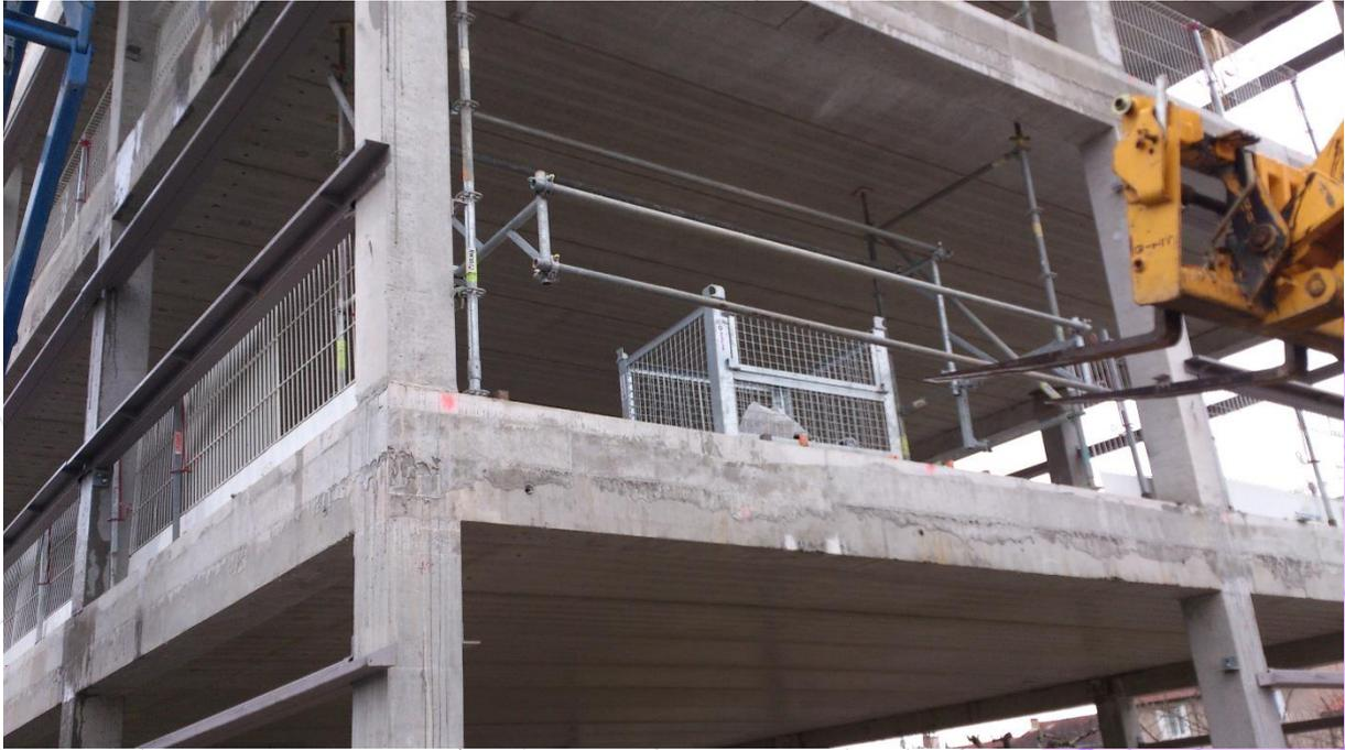
**Position 2 :** Le matériel est déposé, la barrière est abaissée côté extérieur. Le compagnon peut travailler en sécurité sur le plancher
