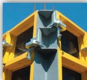
Assemblage par bloc variable des fourrures sur angle extérieur
