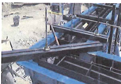
Goulotte en cours de coffrage.
