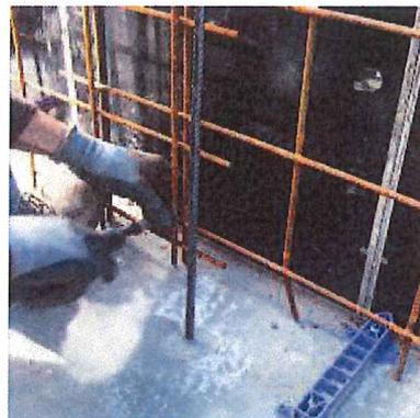
12 = Mettre en place les armatures acier sur le pourtour du bassin.
