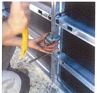
6 = Assembler les panneaux entre eux à l'aide des pinces de jonction (sans les boquer).
