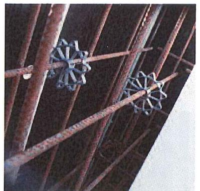
13 = Mettre en place les cales d'enrobage sur les armatures (2 sur la Ht. tous les 0,60m).
