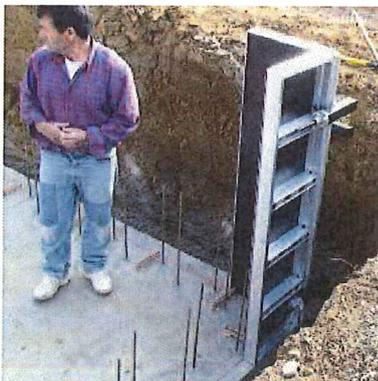
4 = Assembler l'angle Ext. à l'aide de 2 panneaux 0,40x1,50m 1 angle Ext. et 2x2 pinces de jonction.
