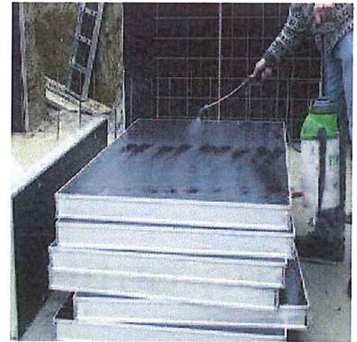
3 = Huiler chaque élément de coffrage sur les faces coffrantes et les profils de contour extérieurs.
