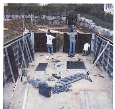
16 = Mettre en place les panneaux intérieurs en prenant soin qu'ils soient de même largeur que les panneaux extérieurs.
