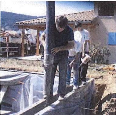
21 = Couler la périphérie du bassin par passe de Ht.0,30m à 0,50m maxi. Vibrer à la verticale des tiges ( Ne jamais vibrer au milieu des panneaux.)
