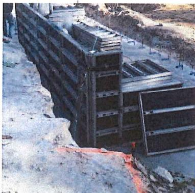
7 = Au regard de la notice de montage DES SKIMMERS, assembler les panneaux extérieurs de larg. 1,00m et le panneau Larg. 0,60m
