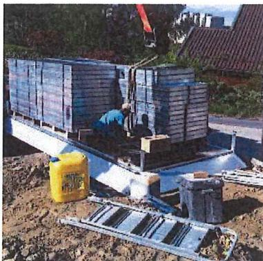
24 – Dès le lendemain, décoffrer l'ensemble et graisser les panneaux pour le prochain chantier.
