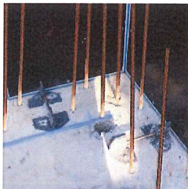
5 = Positionner l'angle Ext. en appui sur les talonnettes et régler l'aplomb et le niveau.
