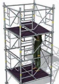
9 - Déplacement du 2<sup>e</sup> plancher à trappe depuis le niveau inférieur.
