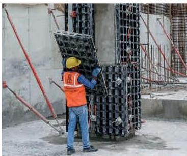
Les panneaux multifonctions Duo permettent de réaliser des poteaux carrés et rectangulaire de 15\*15 à 55\*55 cm en trame de 5 cm
