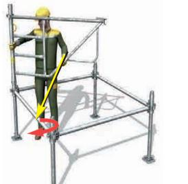
2 - Depuis l'intérieur de la tour, pose du 1<sup>er</sup> cadre dans l'axe de la diagonale puis rotation pour le verrouiller.
