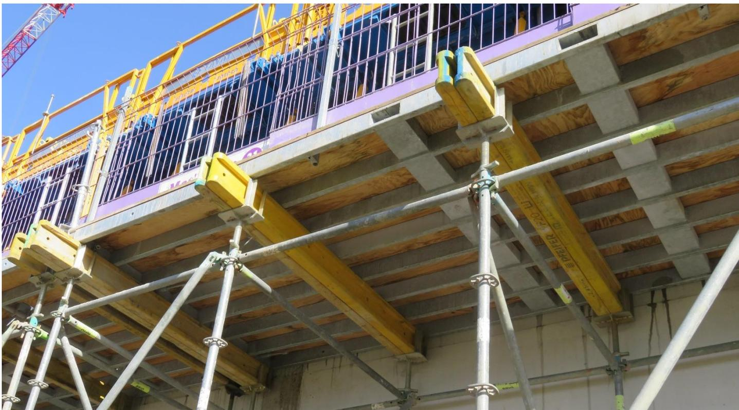
Le système de coffrage horizontal MATADOR est principalement utilisé dans le domaine du génie civil, en plateau support de banches et en tables de balcon
