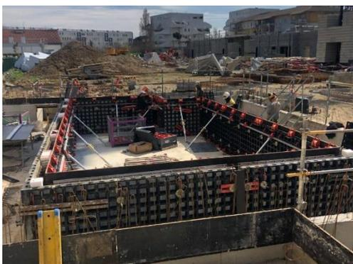
Le matériau de base de la production d'éléments DUO consiste en des fibres enrobées de polymère.
