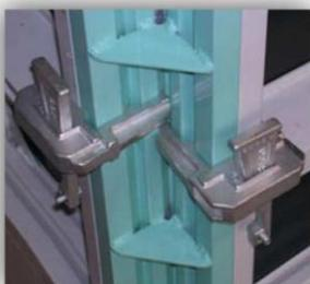
Assemblage par bloc variable des fourrures sur angle intérieur
